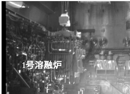
参考写真 1号溶融炉の取外し時の状況 (平成15年)
