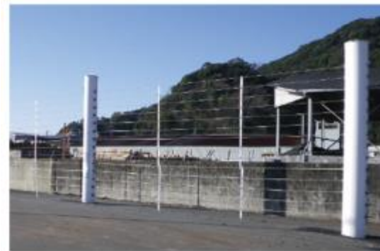
津波漂流物捕捉施設
