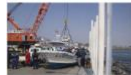
津波漂流物の捕捉状況の例(えりも港)
