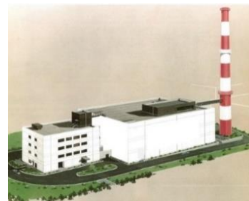
ガラス固化技術開発施設 (TVF)
