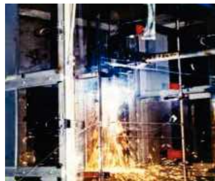
プラズマ切断
