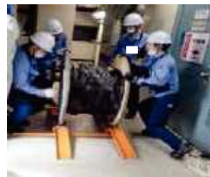
可搬型蒸気供給設備 (本設備が使用できない場合の漏えい液移送用蒸気設備)
