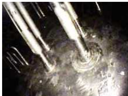
②貯槽上部配管の観察 (予備貯槽)
