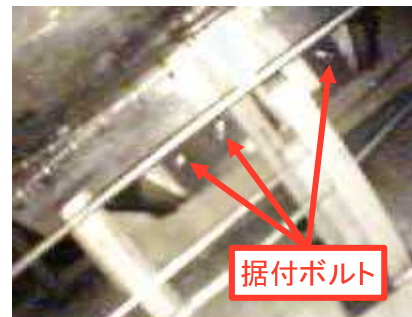
③据付ボルトの観察 (予備貯槽)
