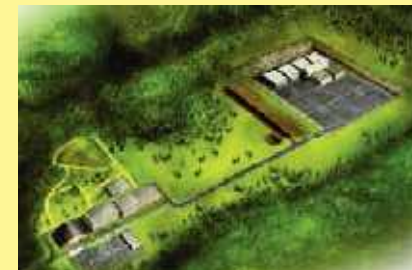
浅地中処分施設
