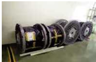
可搬型蒸気供給設備 (本設備が使用できない場合の漏えい液移送用蒸気設備)
