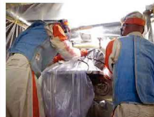
⑤ 点検保守(フィルタ交換)
