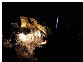
がれき撤去(夜間)
