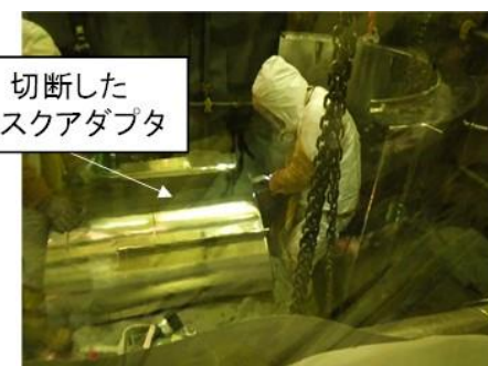
作業員による直接解体 (肉厚25 mm未満)
