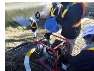
自然水利からの取水
