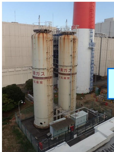
撤去前 (令和2年9月)
