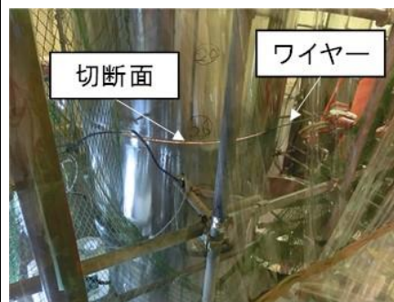
ダイヤモンドワイヤーソー による遠隔解体
