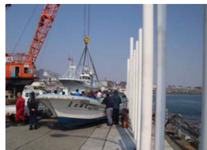
津波漂流物の捕捉状況の例 (えりも港)
