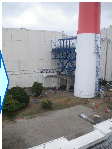
解体撤去後 (令和2年11月)
