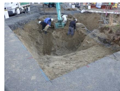
防護柵の設置場所の試掘状況(令和3年12月)
