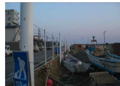
津波漂流物の捕捉状況の例 (十勝港)
