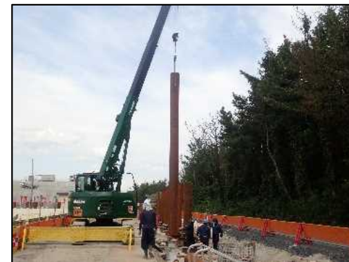
鋼管杭設置
