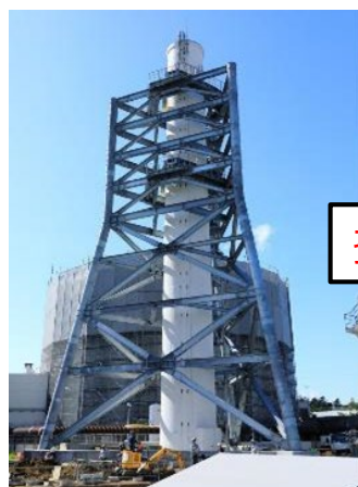
排気筒の補強工事
