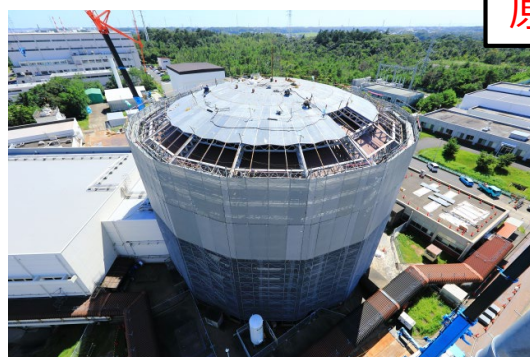
原子炉建家の屋根の補強工事
