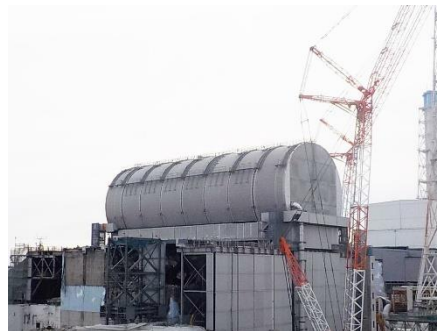
燃料取り出しカバー設置 (2018.2.21)
