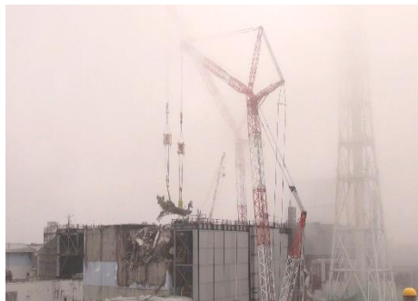
使用済燃料プールからの燃料交換機撤去 (2015.8.2)
