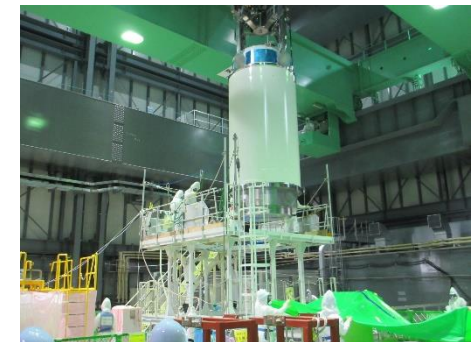
使用済燃料プールからの燃料取り出し (2014.12.20)
