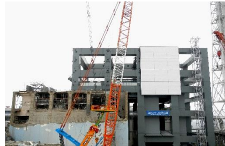
建設中の燃料取り出しカバー (2013.5.29)
