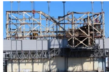
Xブレース撤去作業開始 (2018.9.19)
