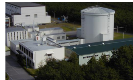
NSRR原子炉建家外観
