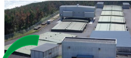
保管廃棄施設・L (屋外の半地下ピット式)
