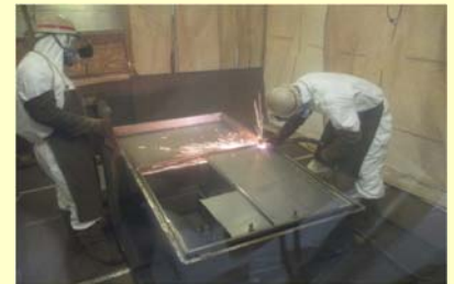
《プラズマ溶断機にて細断作業中》
