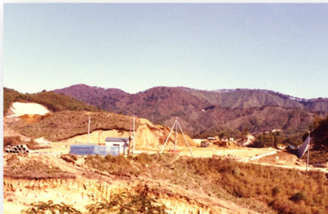
ウラン濃縮パイロットプラント造成工事(1977年頃)
