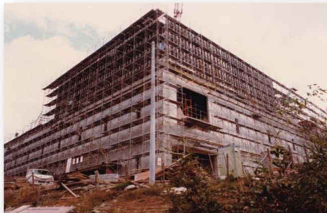
建設中の製錬転換施設(1980年頃)
