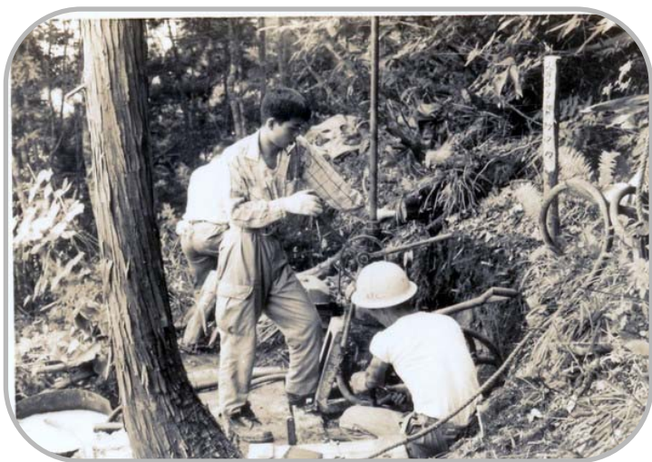
1962年7月 高清水におけるボーリング調査
