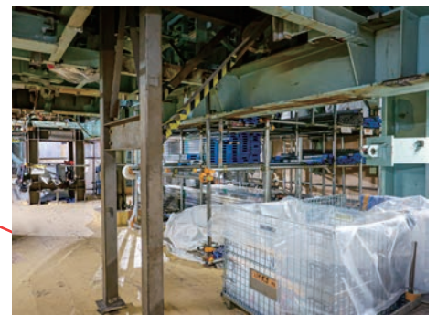
既に撤去を終えたAループ
