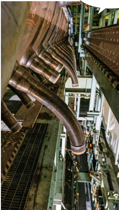
原子炉上部にある蒸気ドラムは先に配管を切断してから撤去されます。高所で狭い空間での作業を安全に進めていくため、Aループで得られた知見がBループにも役立てられています。
