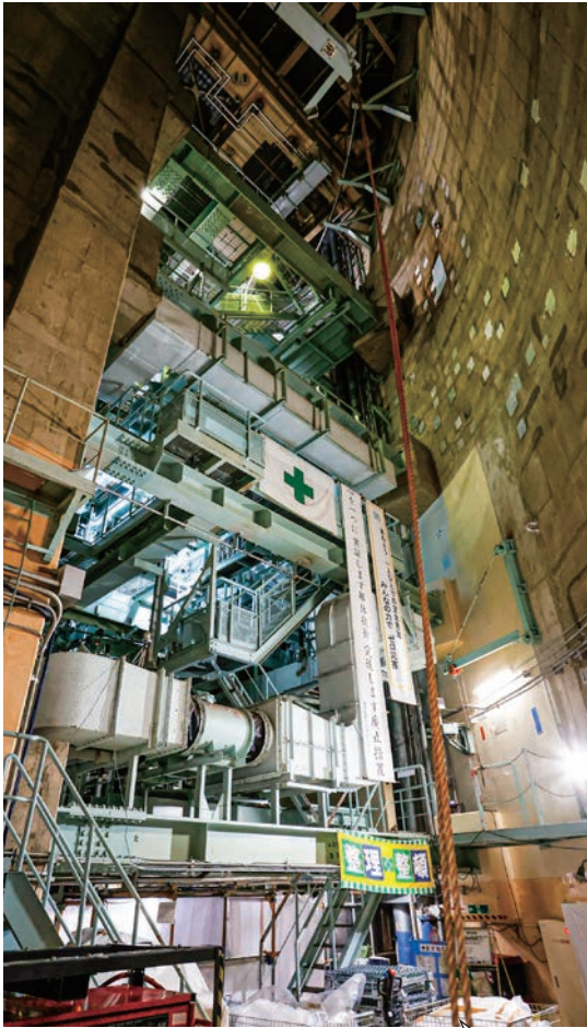
1階フロアから見上げたAループ全景。同様のBループにおいても高さ約30mの大空間に作業ハウスや足場を組んで解体撤去しています。
