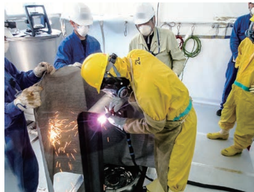
スマデコでの管理区域を想定した解体訓練の様子
