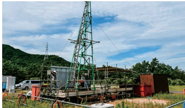
「もんじゅ」敷地内におけるボーリング調査の様子 (令和3年8月26日撮影)
