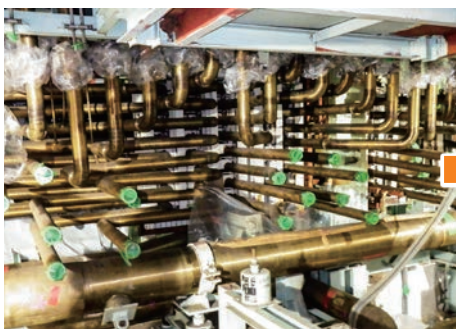
切断前（断熱材撤去状態）
