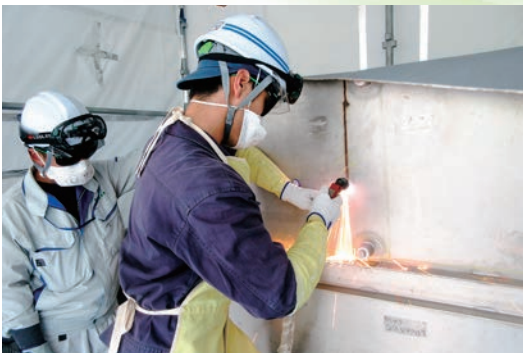
写真① 解体訓練の様子(プラズマ切断)
