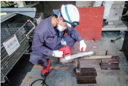
写真② 解体訓練の様子(バンドソー切断)
