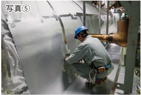
蒸気ドラム廻りの養生作業
