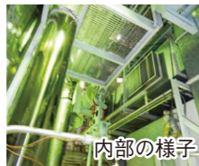
蒸気ドラム廻りの養生作業
