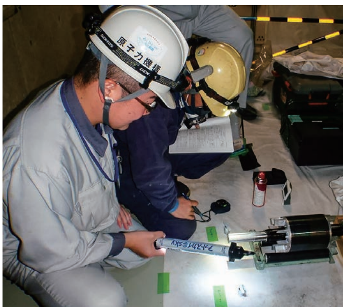
電動機の点検で傷の有無を確認している様子
