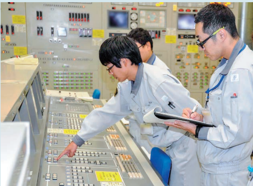
燃料体の処理作業を行う操作員（燃料取扱設備操作室にて）
