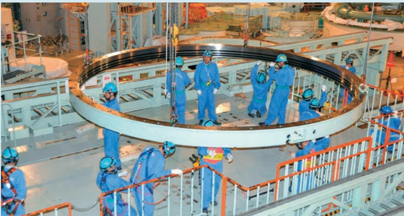
設備点検している現場の様子
