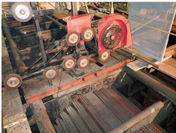
【写真1】海水冷却管の一括切断(ワイヤーソー)
