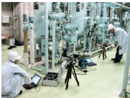
コンピュータ上で解体作業をシミュレーションするために解体予定の現場を撮影する様子
