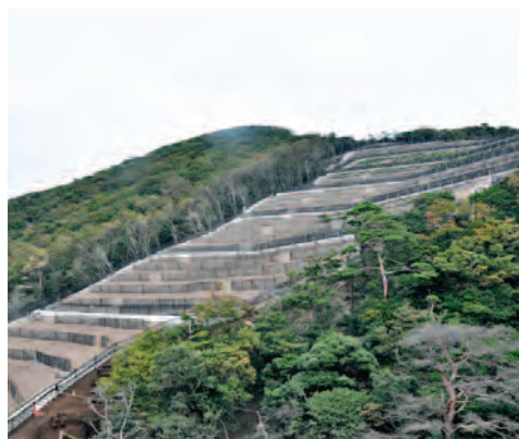
工事で土を削り取った斜面の緑化。吹き付けた種を守るために防風ネットを設置した
