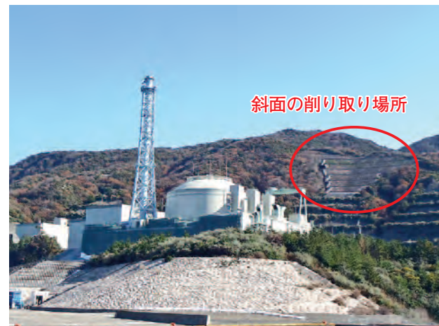
背後斜面の工事場所
