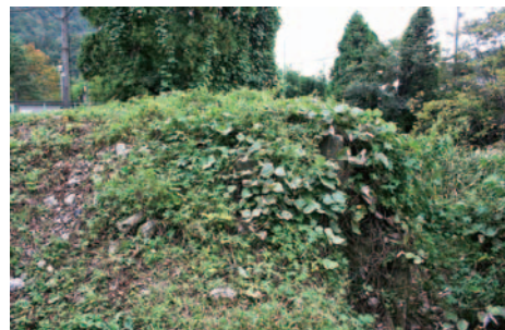
疋田橋付近にある橋台とおぼしき遺構(右側が川)
