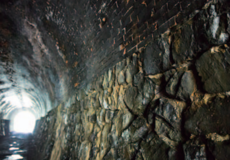
小刀根トンネルの内部
