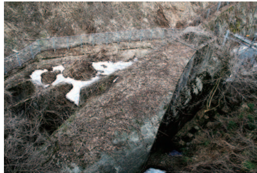
365号から見た柳ヶ瀬トンネル長浜側口。山からパイプ状に突き出したトンネルの上に覆いかぶさるように排煙装置の跡と思われる構造物が残る(白いものは残雪)
