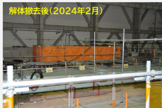
高圧・低圧タービンカバー解体撤去
