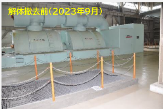
高圧・低圧タービンカバー解体撤去
