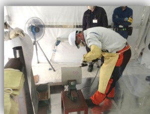
「ふげん」実機材を用いた解体技術研修の様子
