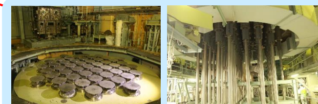
制御棒駆動装置 (左：上部、右：下部)
