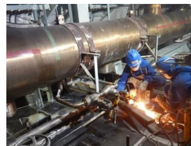
再循環ポンプ吸込み管解体
