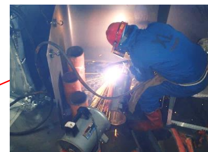
主蒸気管細断作業
