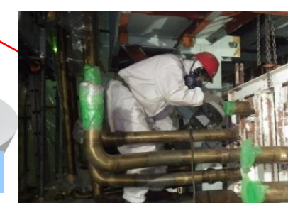
上昇管(原子炉出口管)切断
