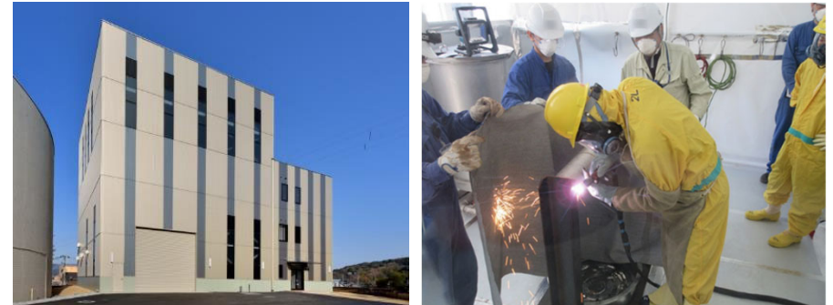
実機材を用いた解体作業の実習 （スマデコでの「解体技術研修」2021年5月）
