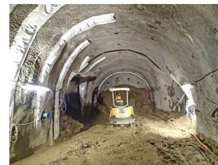
深度 500m 研究アクセス北坑道 埋め戻し（R2.7）
