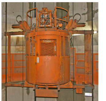
エレベータ(主立坑)
