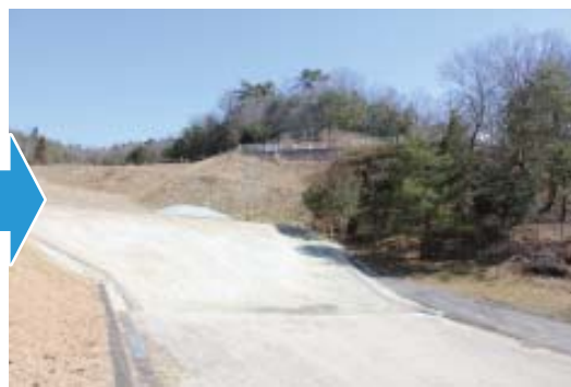
措置完了後の捨石集積場などの状況（平成29年2月）
