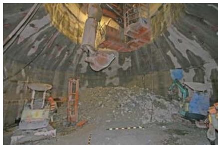
主立坑の深度500mの様子
