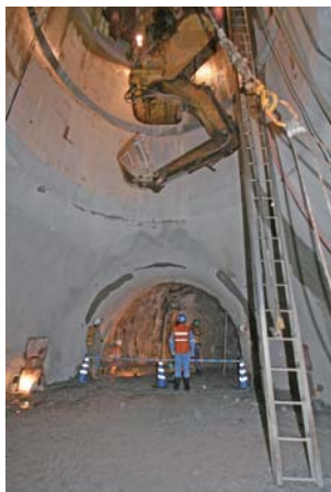
換気立坑（深度500.2m）
