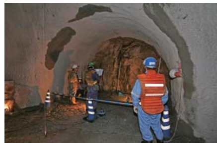
深度500mの調査研究用の水平坑道の壁面観察
