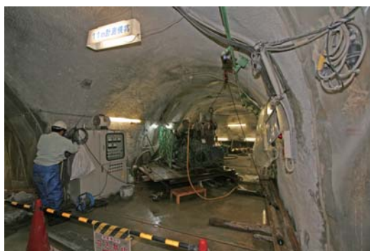
ボーリング調査の様子
