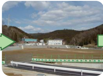
用地内の造成工事完了 (平成15年3月)
