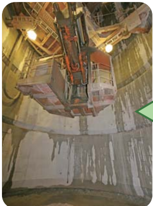
主立坑(深度459.6m) (平成22年7月23日)
