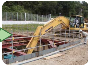
立坑の掘削工事の様子 (平成15年7月着手)
