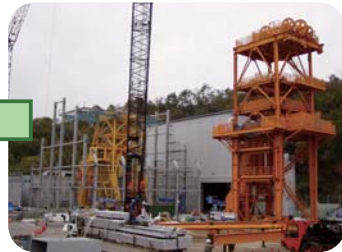
やぐら設備の設置工事の様子 (平成16年11月工事開始)
