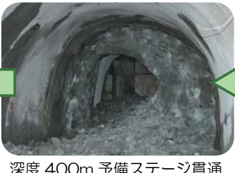
深度400m 予備ステージ貫通 (平成21年10月)
