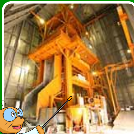
【主立坑のやぐら】
