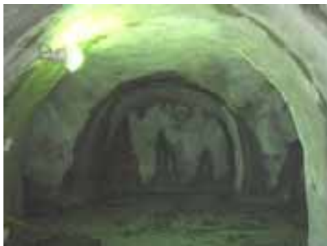
深度 300m の調査研究用の水平坑道 (先端部分)
