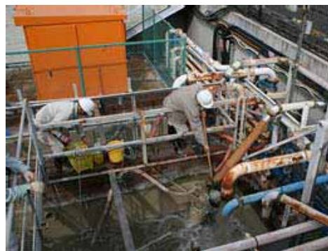
立坑湧水の採取の様子
