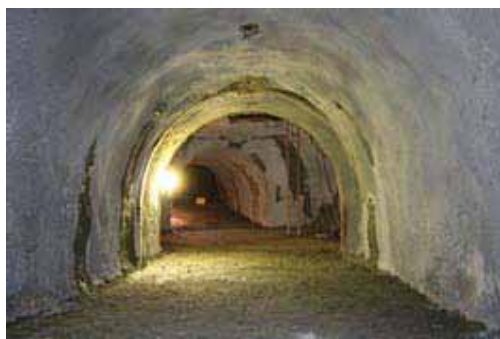
深度300mの予備ステージから換気立坑と ボーリング横坑の方向を見た様子
