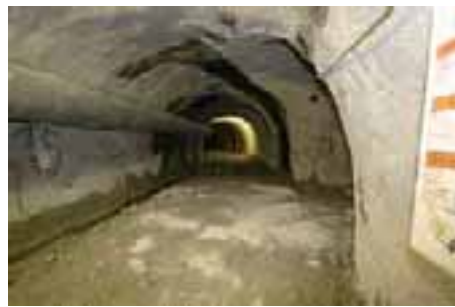
調査研究用の水平坑道の様子
