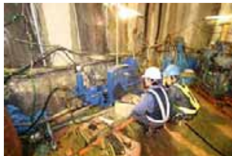
力学ボーリング調査の様子
