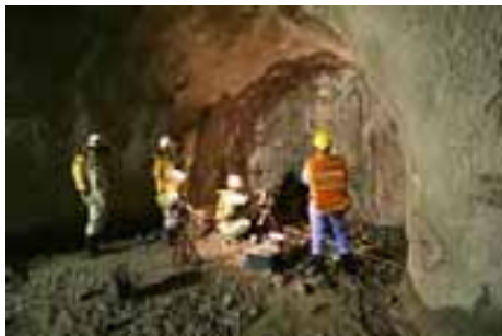
調査研究用の水平坑道の壁面観察の様子
