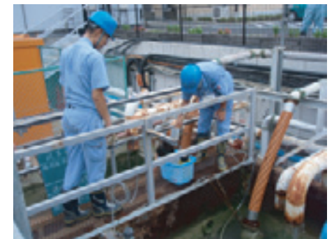
立坑の湧水採水の様子
