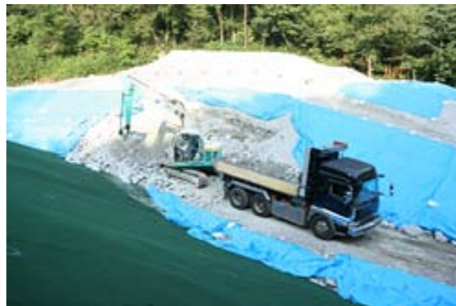
搬出作業の様子（堆積場）
