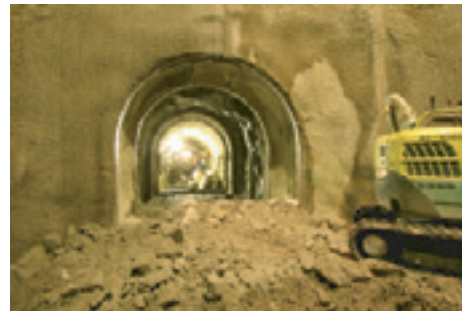
貫通後の様子（換気立坑側より）
