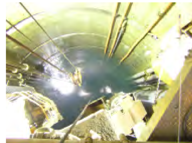
立坑内の様子
