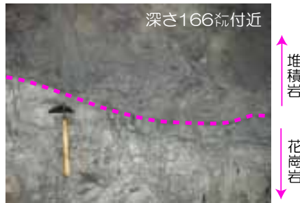
《主立坑の堆積岩と花崗岩の境》
