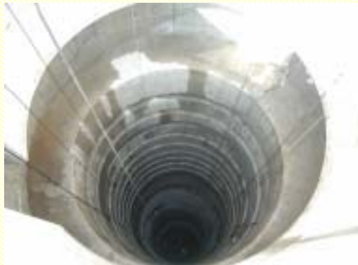
写真は換気立坑 (45.5 ㍍)
