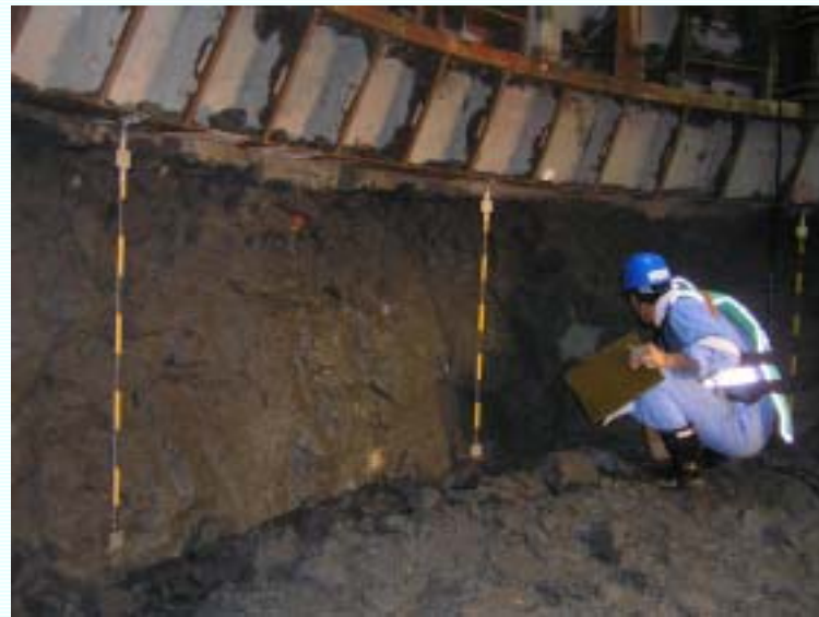
主立坑の内壁の調べている様子（深さ約 25 ㍍地点）
