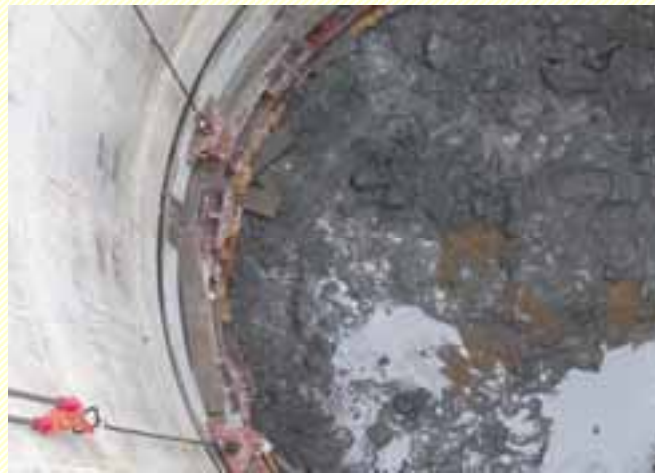
発破作業終了直後の主立坑坑底の中の様子 （写真は地上から坑底を撮影）
