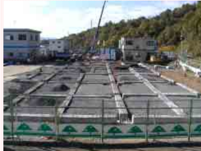
建設管理棟(仮称)の建設工事の様子
