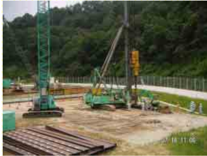
坑口部分の基礎工事の様子
