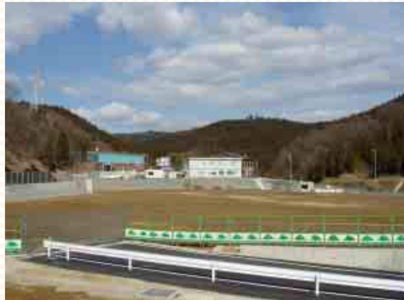
造成工事の様子(3月18日撮影)
