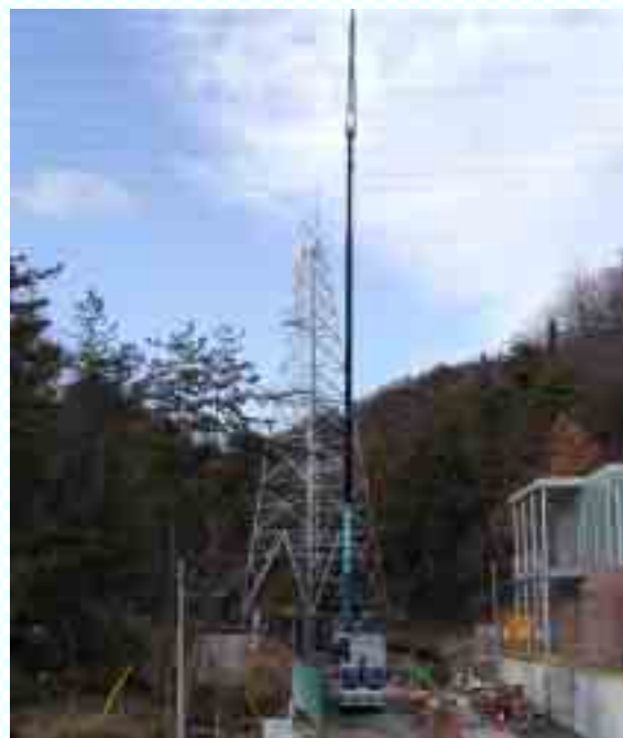
ヤグラの設置工事の様子
