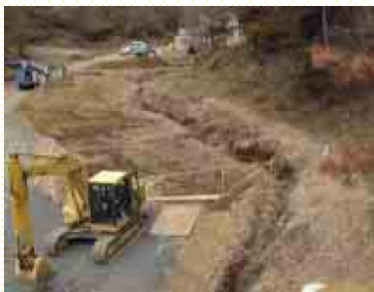
ボーリングを掘るための造成工事の様子
